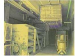
液体窒素24時間供給システム 窒素供給と同時に換気ファン稼働
