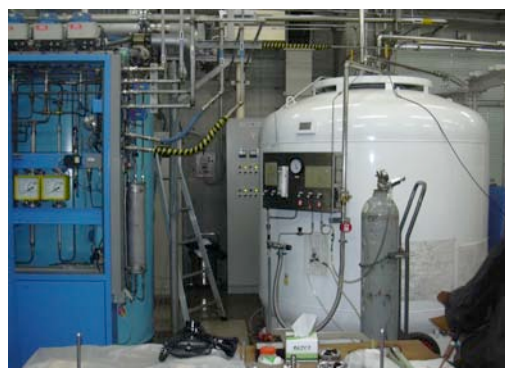
液化機 TCF50（左）とヘリウム貯蔵容器（右）
