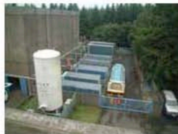
液化窒素貯槽及び回収ガス高圧容器
