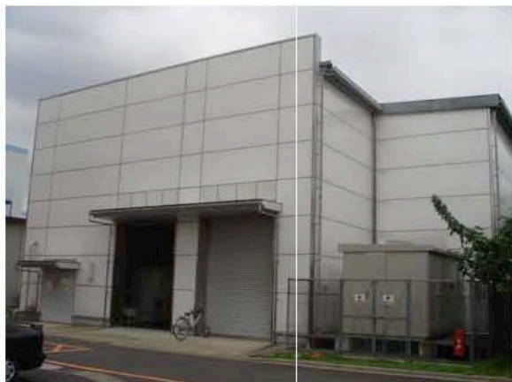
仁科センター液化ヘリウム施設
