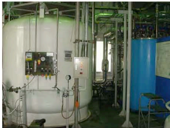
7000 Lの貯槽 (左) とヘリウム液化機 (TCF・50)
