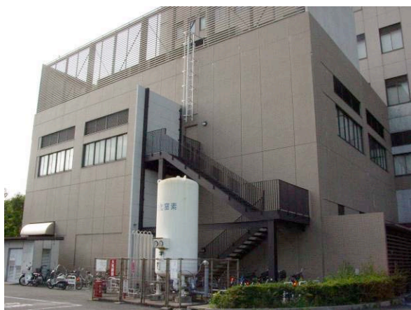
産学官連携機構本館裏正面（1階、ヘリウム液化室）
