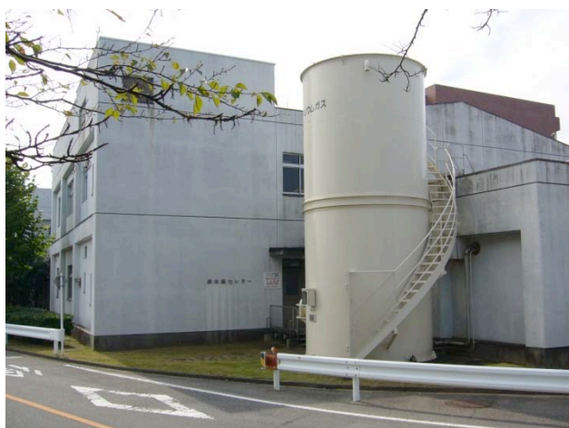
極低温棟 ヘリウムガスホルダー50m 3
