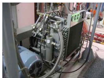
回収用ヘリウム圧縮機 (GreenField C5N210GX)
