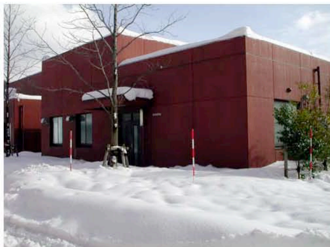
液体ヘリウム貯槽
