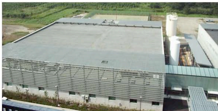
低温・多重極限実験棟（本館より）
